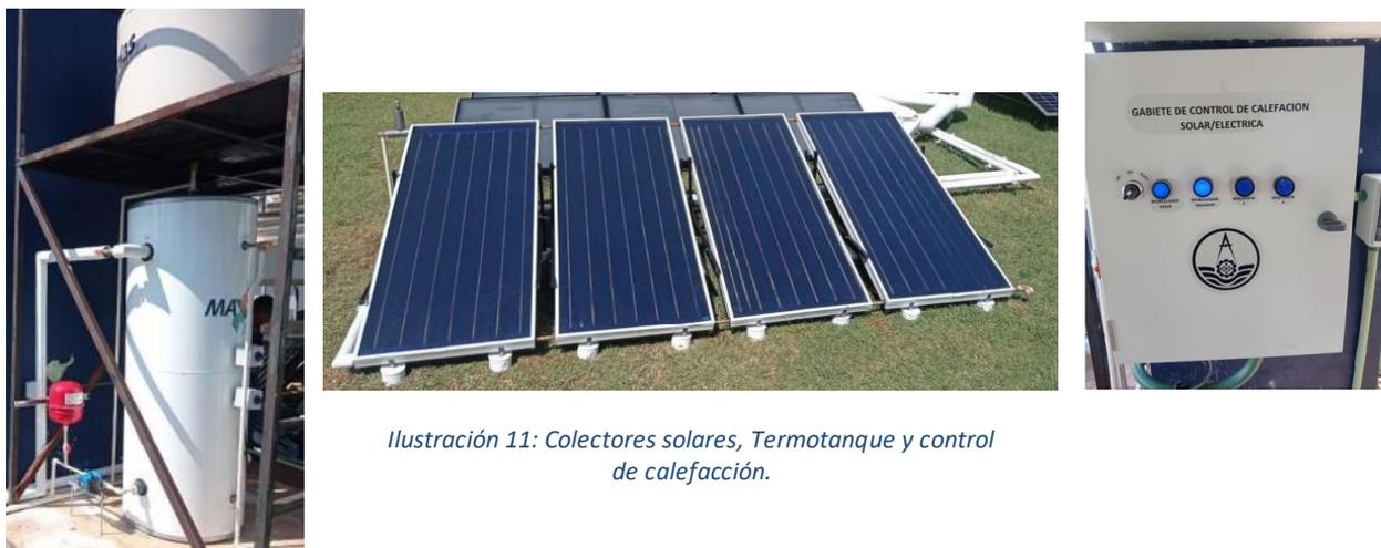
Ilustración 11: Colectores solares, Termotanque y control de calefacción.
